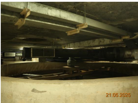
รูปที่ 3.1-20 บ่อดักตะกอน ระบบบำบัดน้ำเสีย แบบ Deep shaft
